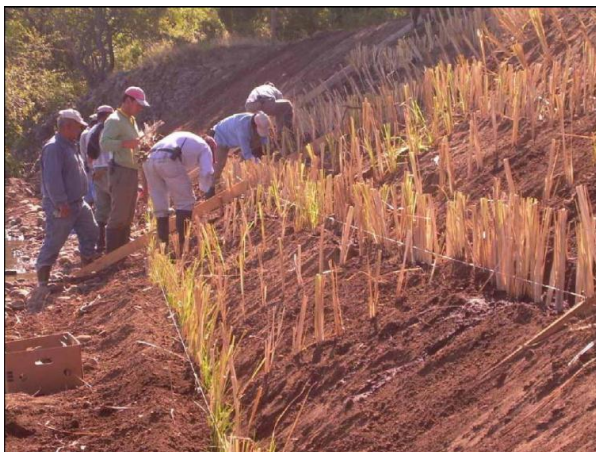
شکل ۳- کشت گیاه و تیور در سطح شیب‌دار ساحل رودخانه در جهت طولی و عرضی
