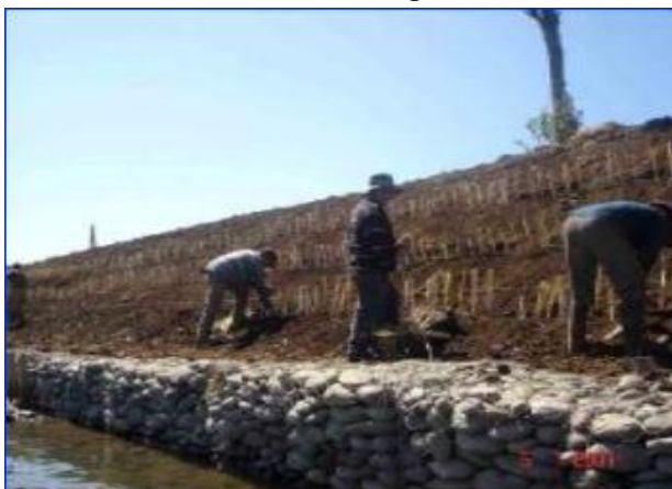
شکل ۴- حفاظت ساحل رودخانه با کشت گیاه و تیور توأم با گابیون
