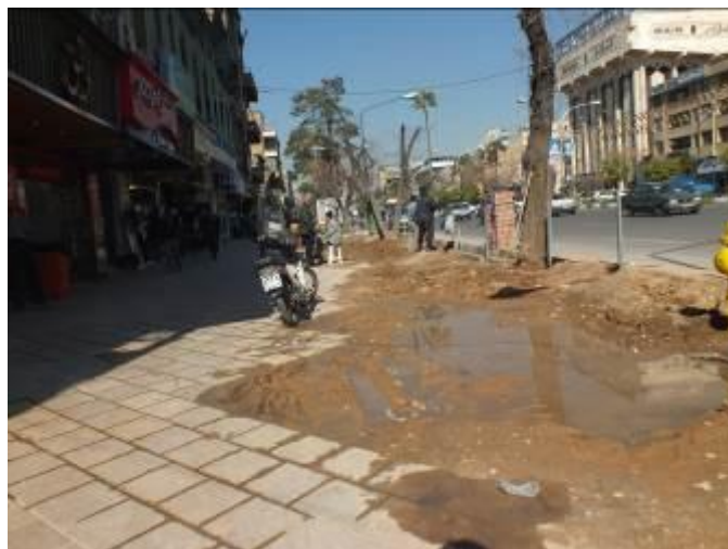
شکل ۵- فقدان سیستم زه کشی مناسب برای دفع آب های سطحی
