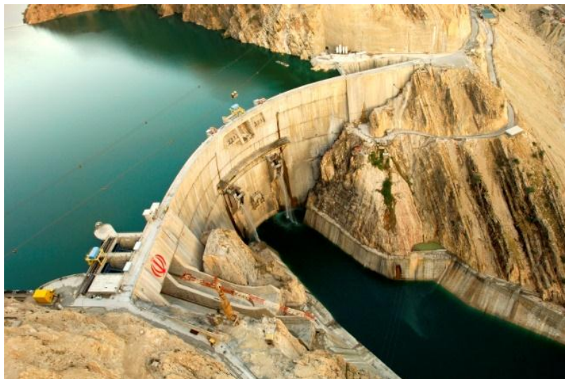
شکل ۱- سد بتنی دوقوسی کارون ۳
